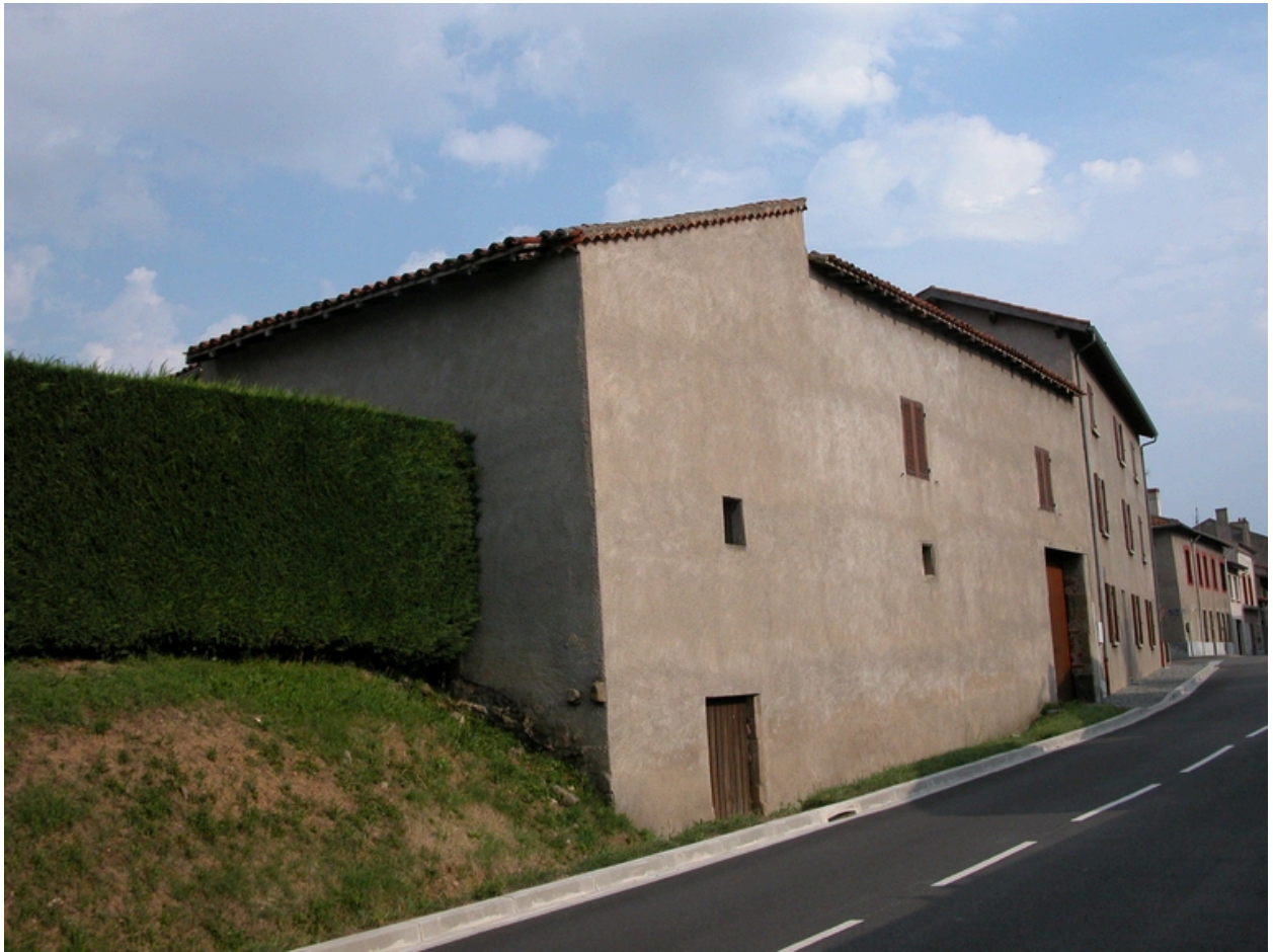
Faubourg du Chauffour, route de la Boën. Demeure, puis ferme, puis maison (1999 AD 40). Vue générale.
