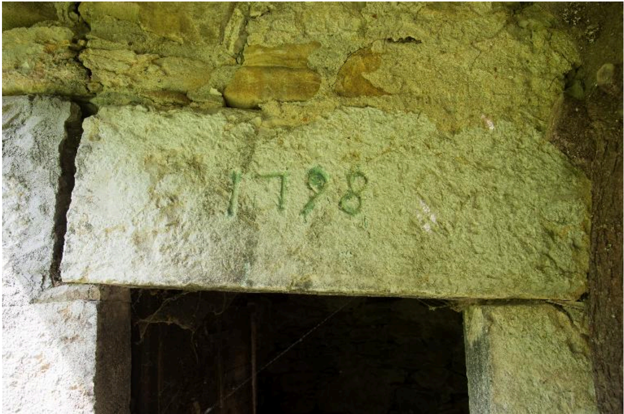
Date gravée sur le linteau de porte du chalet de la Charbonnière (Entrevernes).
