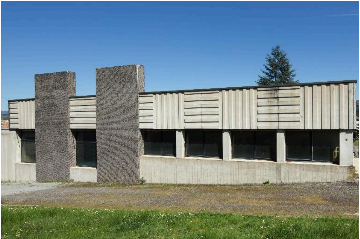
Ateliers : façade nord, détail
