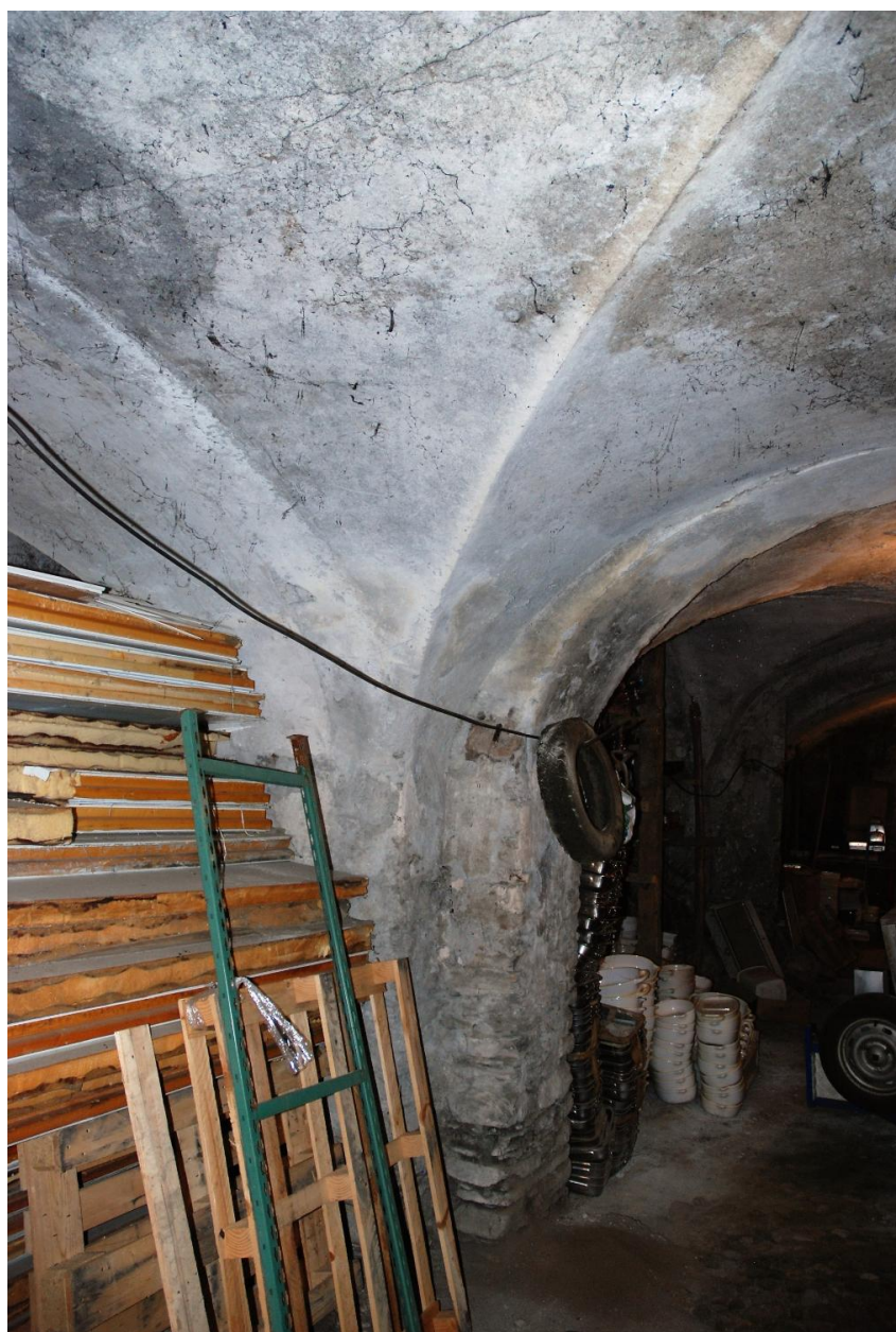
Vue intérieure de la pension de famille, étage de soubassement : boutique voûtée, vue vers le nord-ouest. Détail de la retombée des voûtes sur une pile de maçonnerie.
