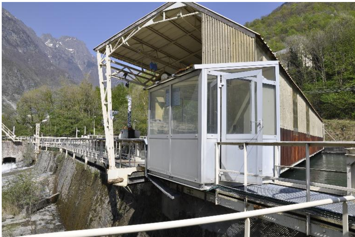
Vue de la cabine de surveillance du barrage
