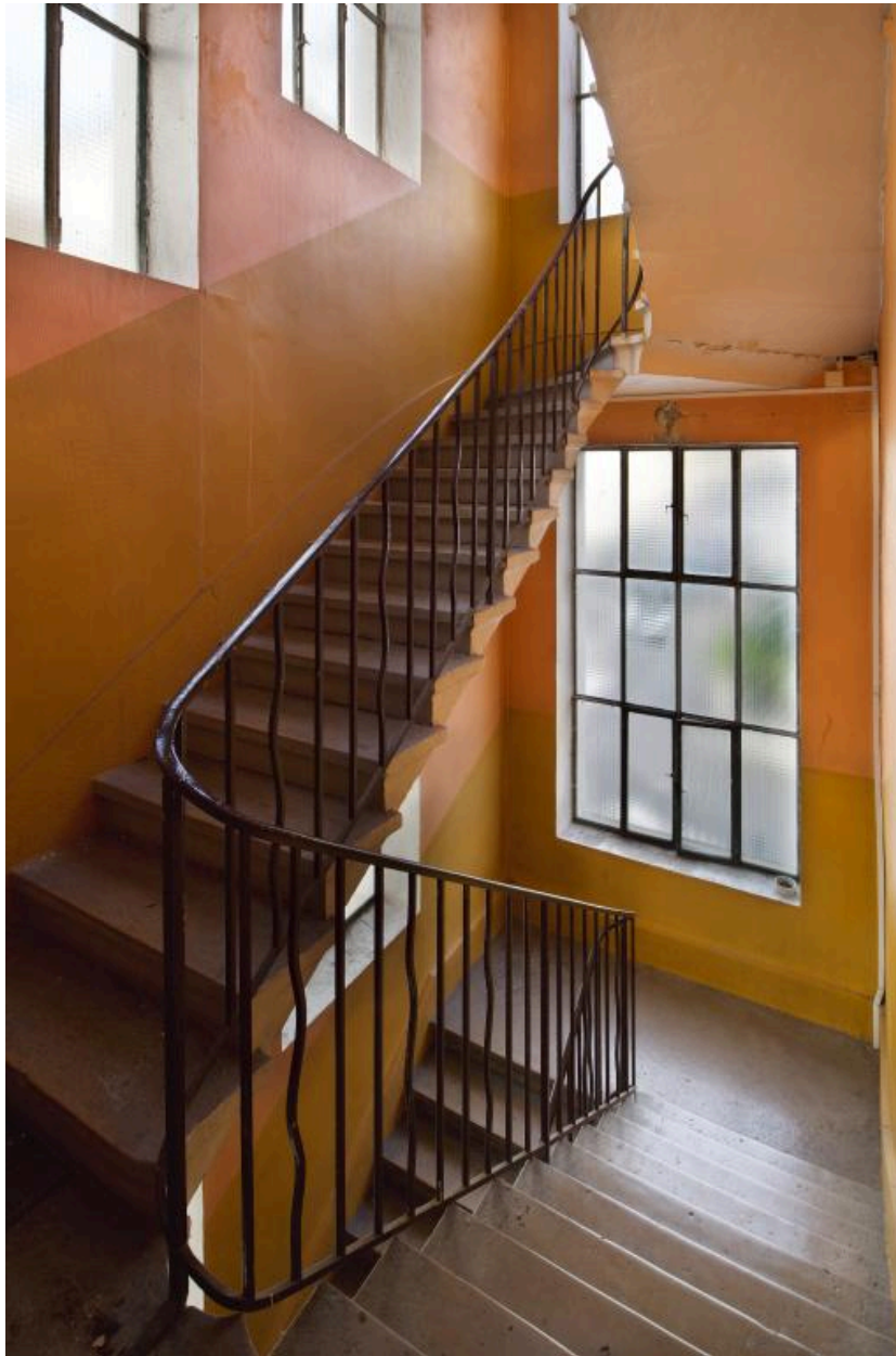
Escalier intérieur d'accès à l'étage des bains-douches
