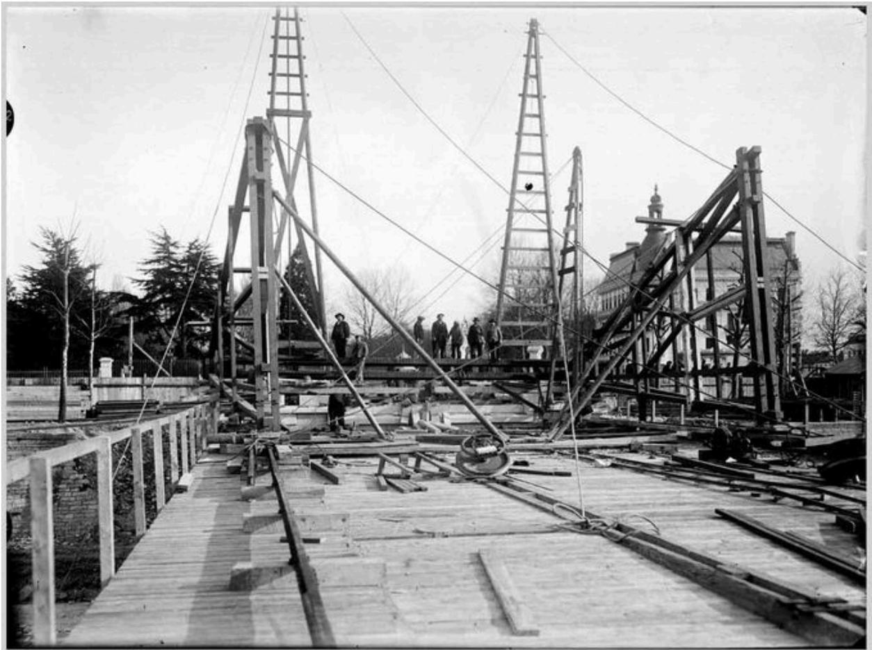
La construction du pont de la Boucle. La pose du tablier. [1902]. 1 fotogr. : n. et b. (AM Lyon. 15 Ph 1806)
