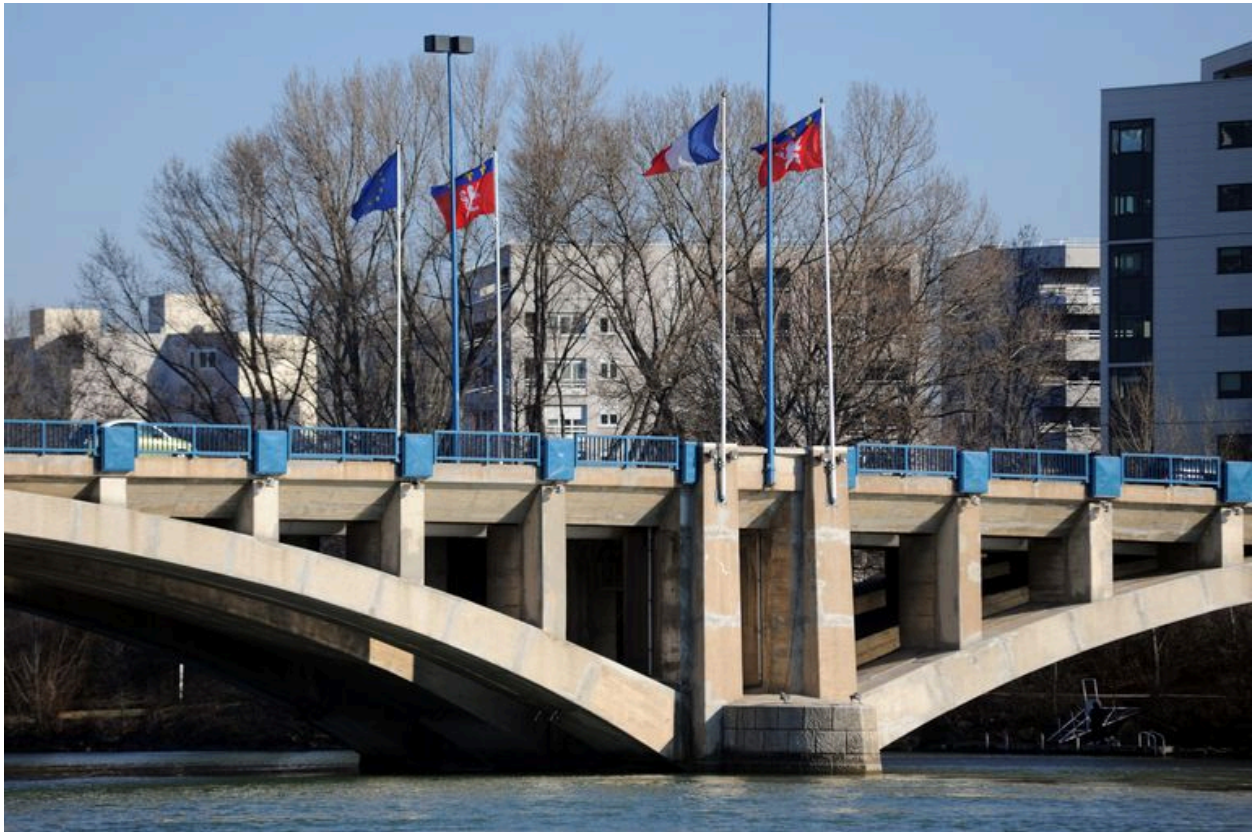
Pile, face aval, vue générale (depuis la rive droite)
