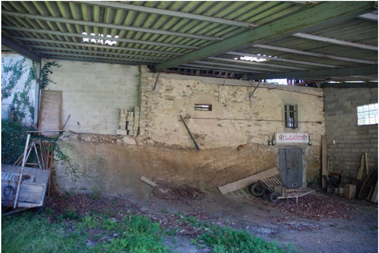
Vue de l'étage de soubassement, côté nord.
