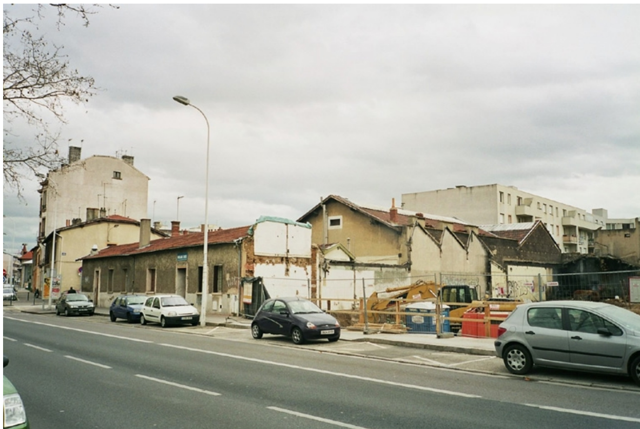
Vue générale nord-est
