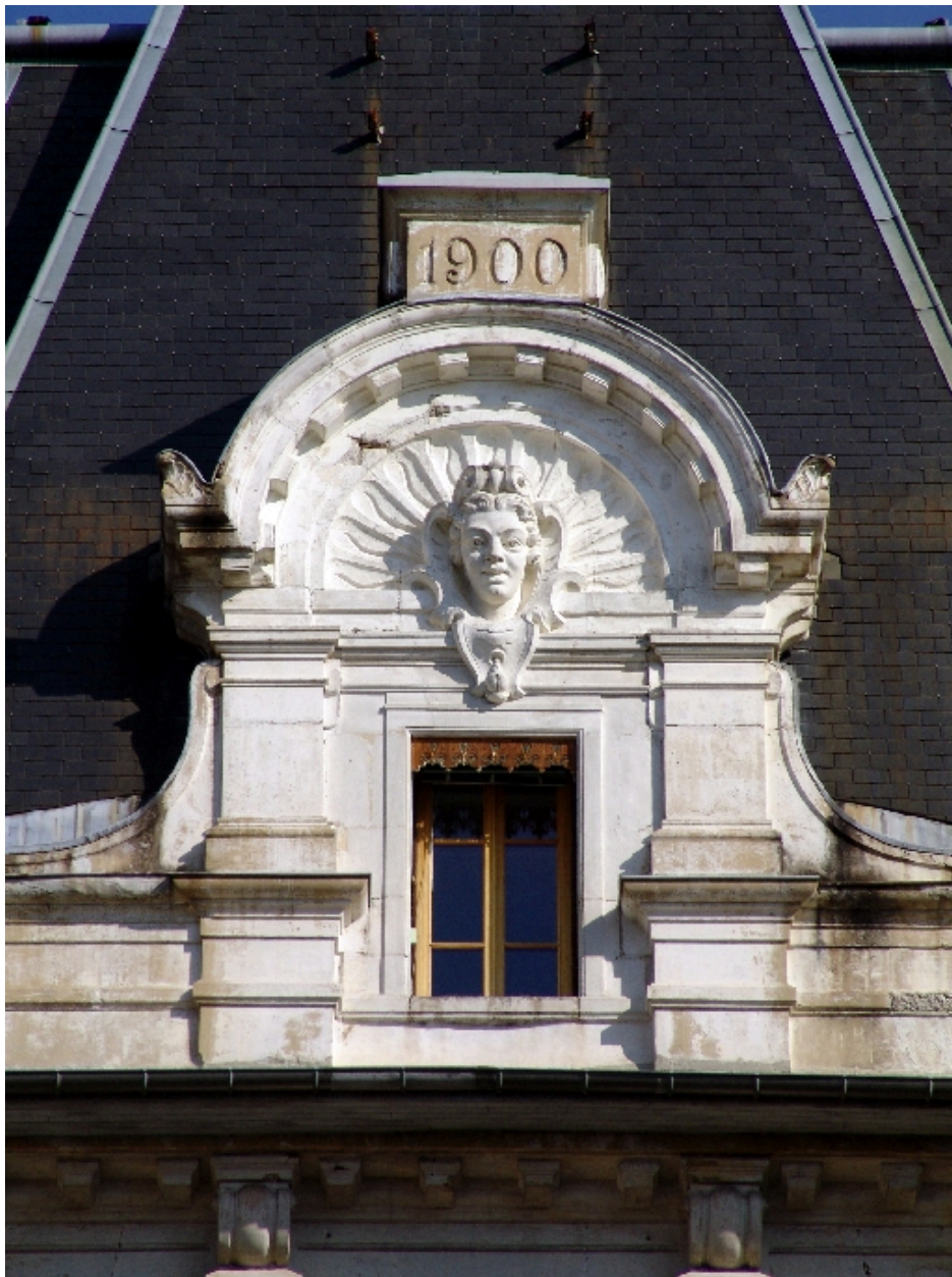
Détail d'une lucarne de l'avant-corps
