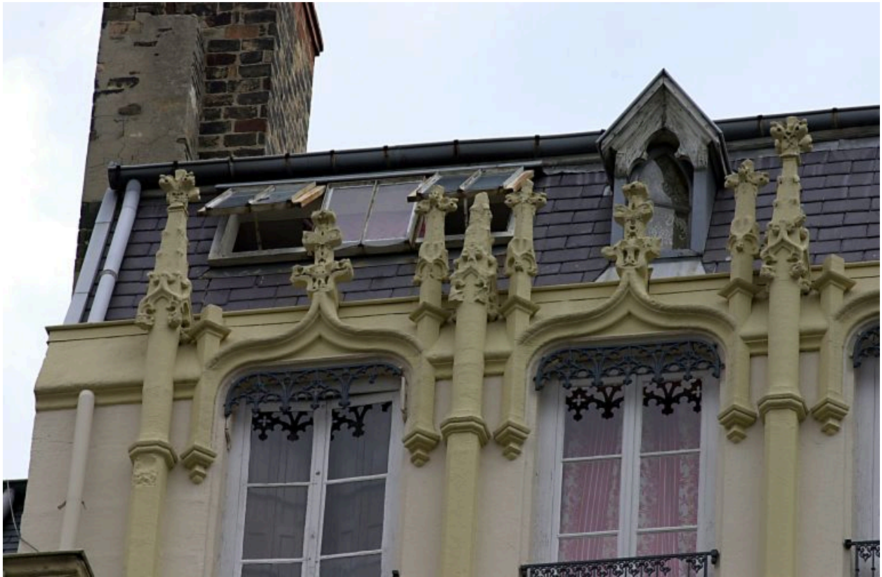
Façade principale sur la rue Chavanne, baies du dernier étage
