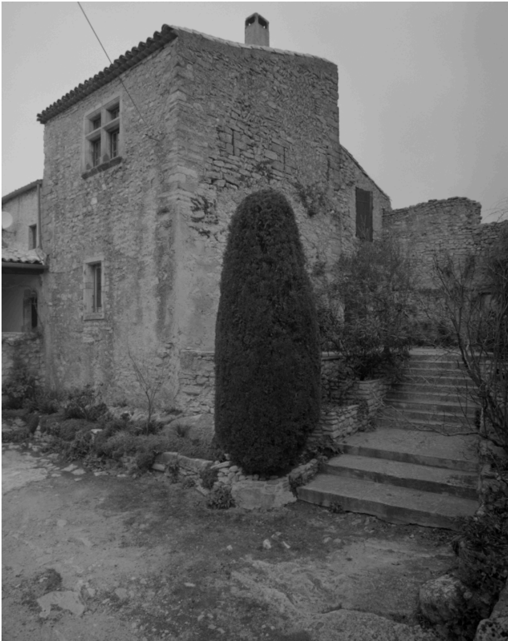
Vue du corps de bâtiment nord-est en retour sur cour.
