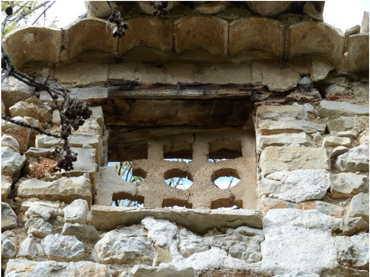
Baie d'envol de pigeonnier en mortier de gypse, ferme au hameau du Génisseau.
