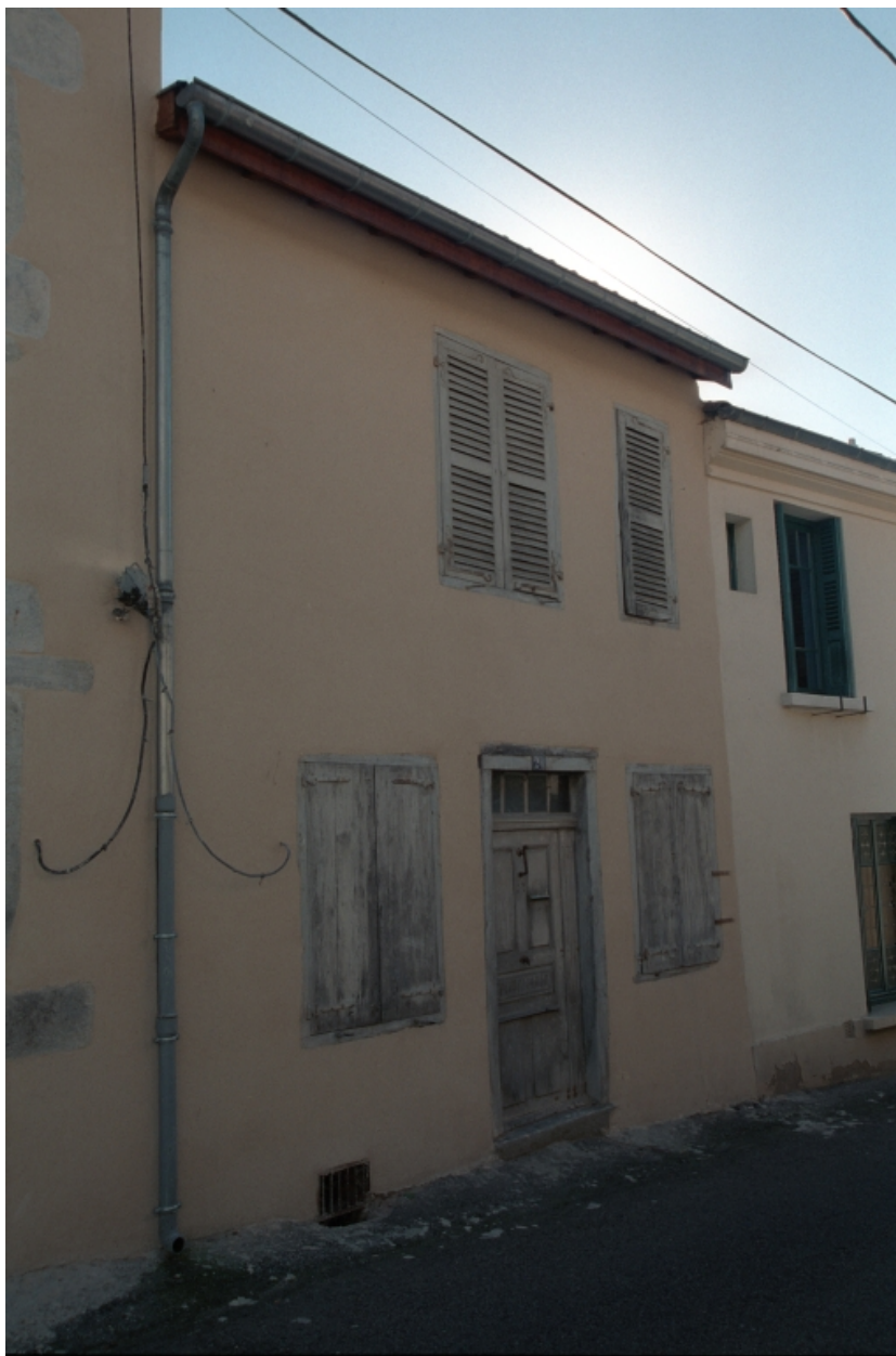
Boën, îlot 13, Ph. Raymond (rue) 28. Vue générale de la façade sur rue.
