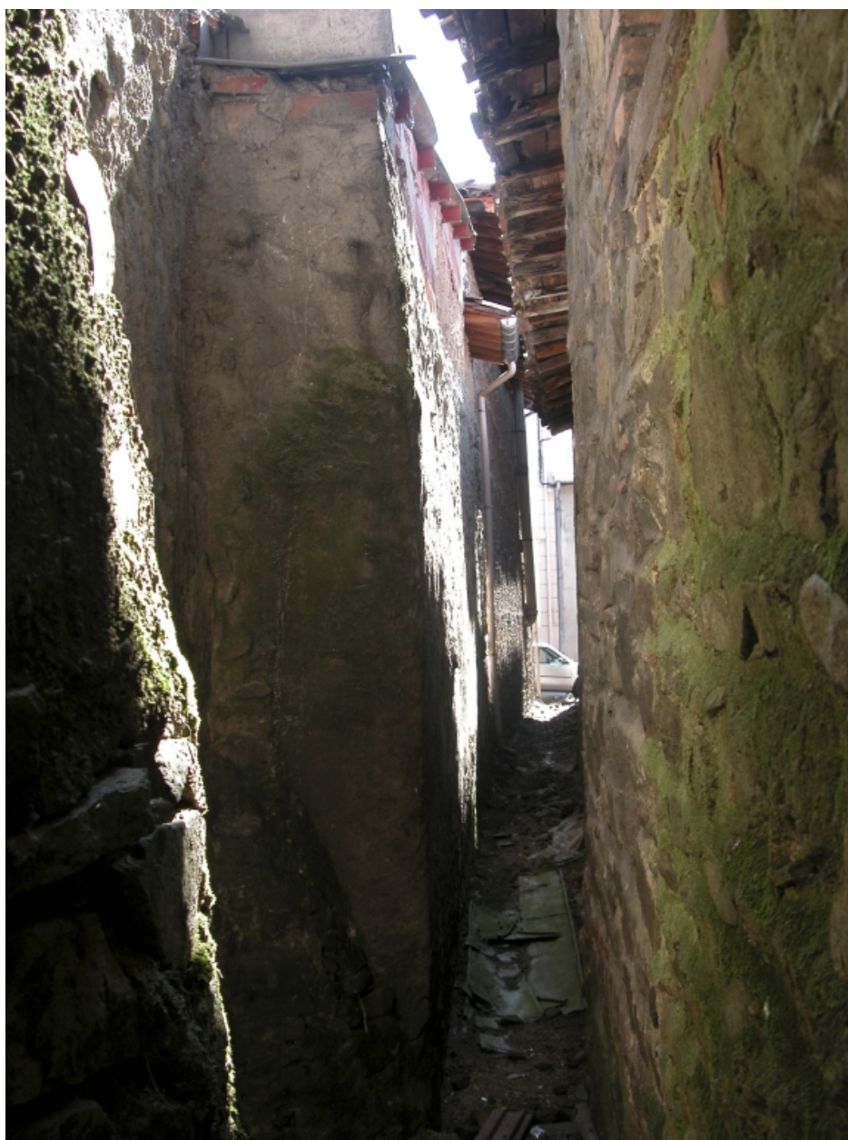
Îlot 2. Saint-Jean (rue) 32, 34. Vue générale de la traversière entre les deux maisons depuis le fond.
