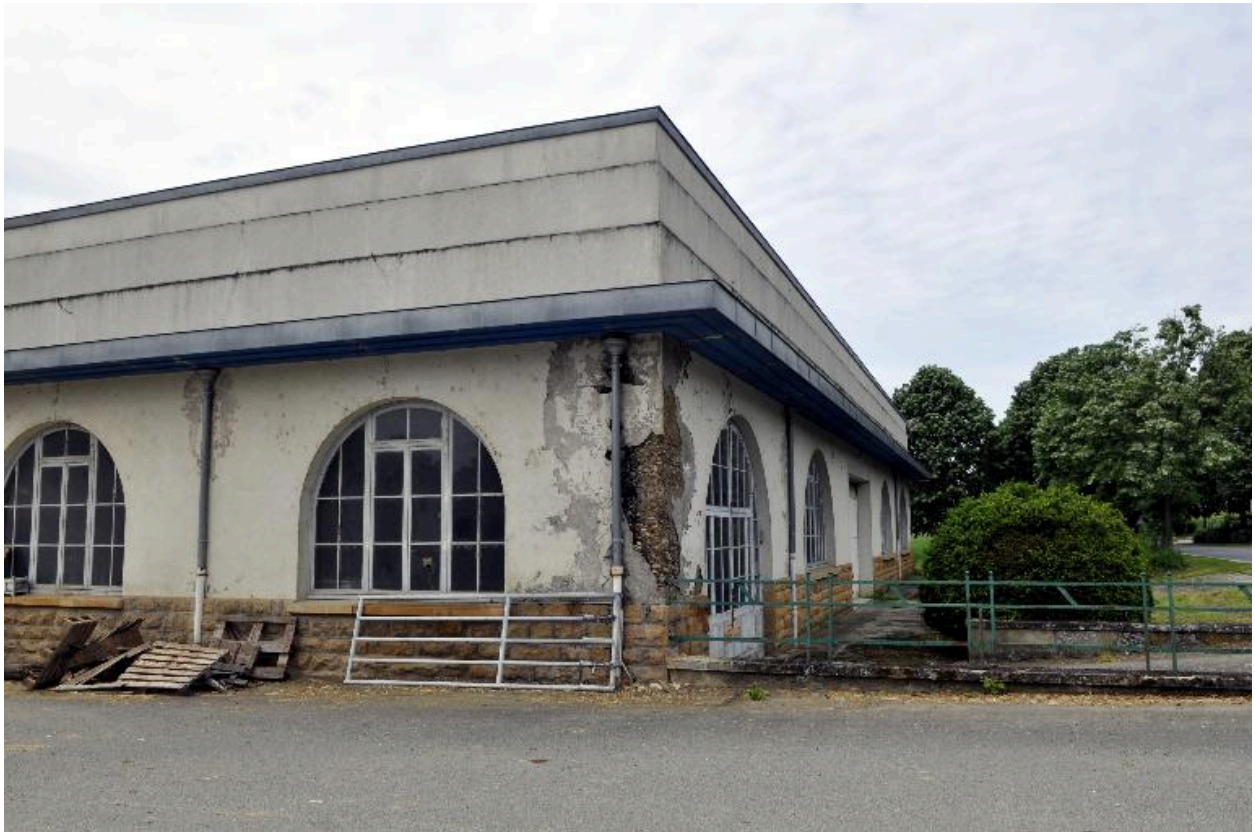
Atelier, vue partielle depuis l'est
