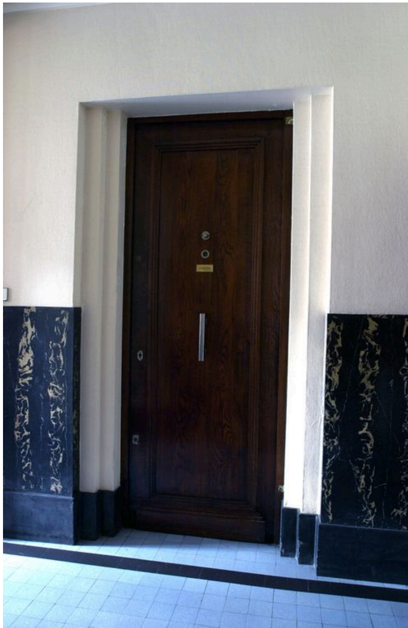
Rez-de-chaussée, porte palière
