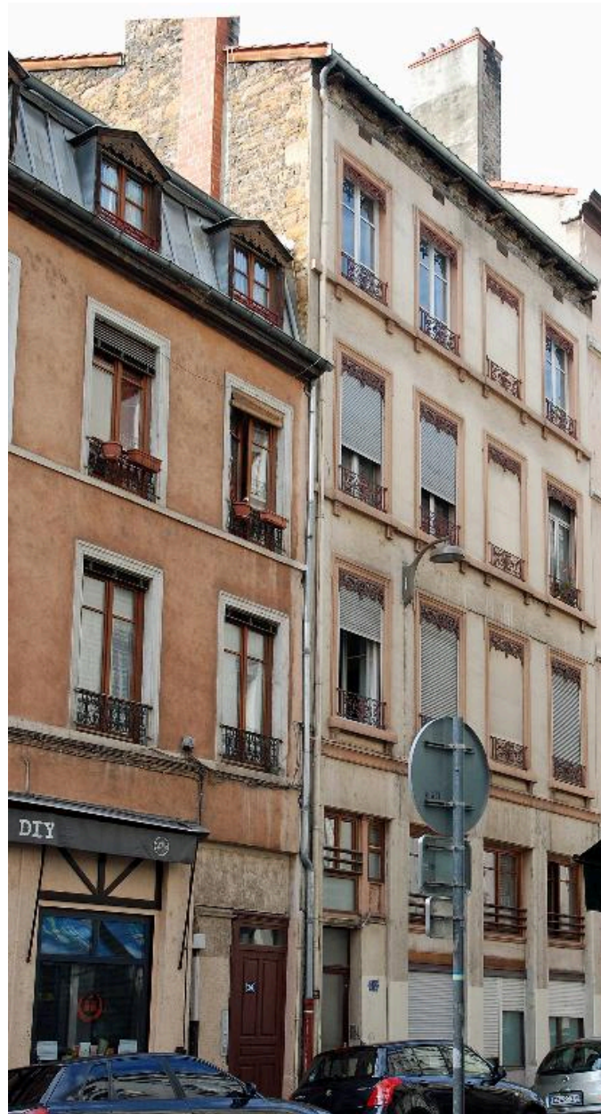
Vue générale de l'élévation sur rue
