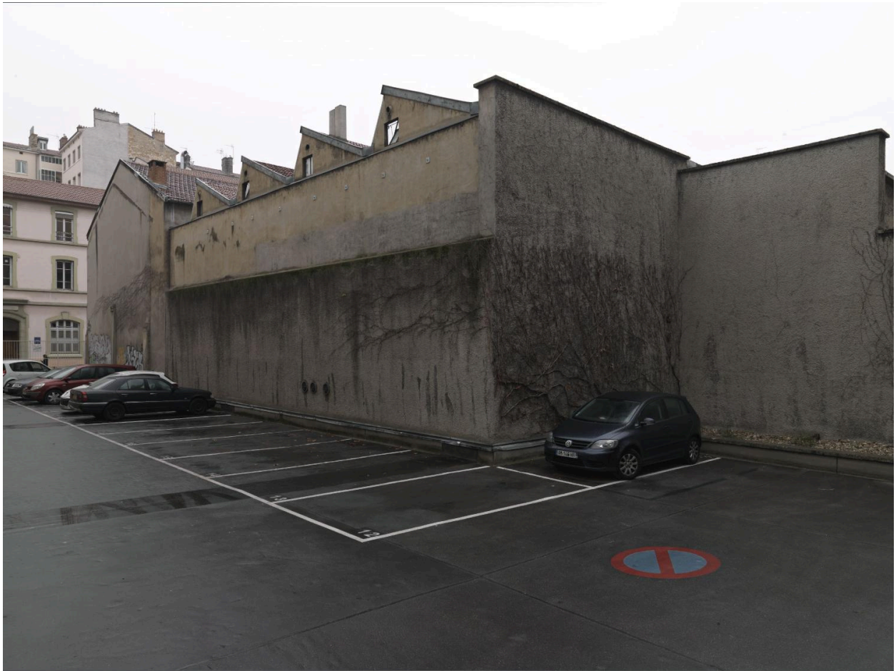
Vue sur cour du site (vue ouest)
