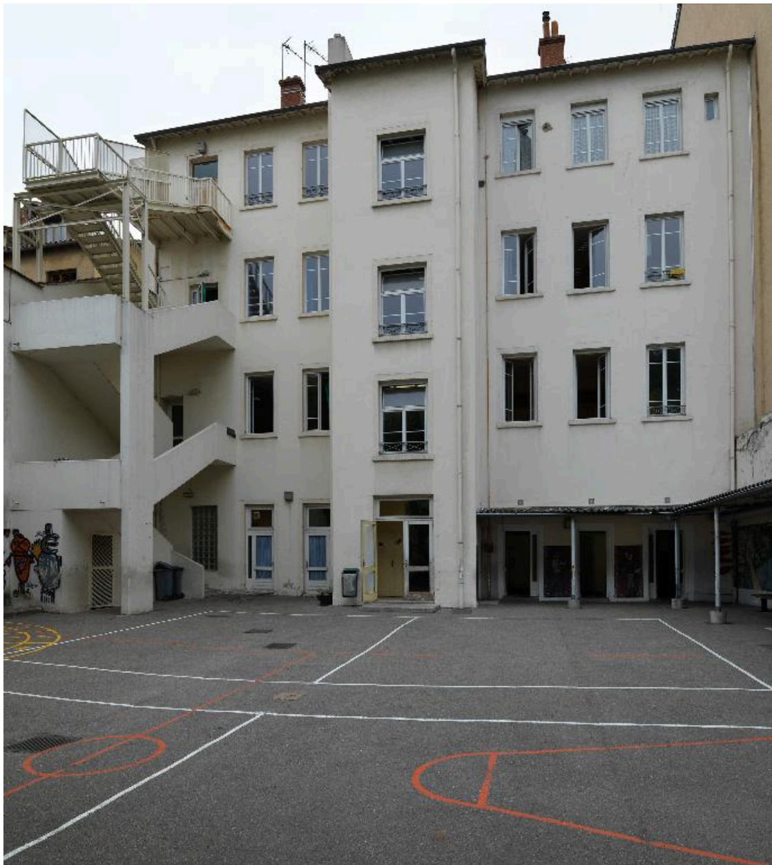
Vue générale de l'élévation sur cour, avec l'escalier de secours construit en 1972
