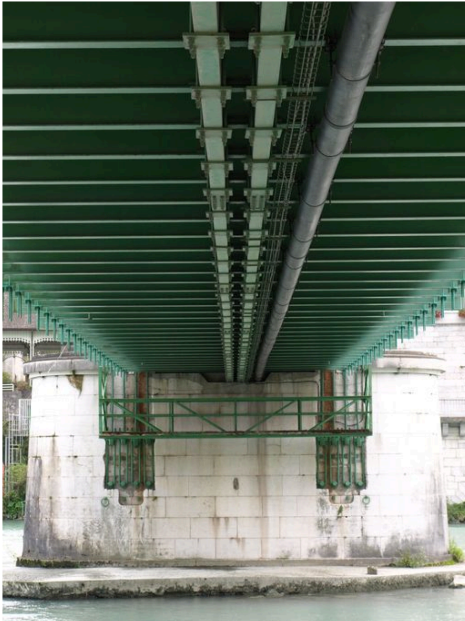
Vue du dessous du tablier, travée droite (depuis la rive droite)
