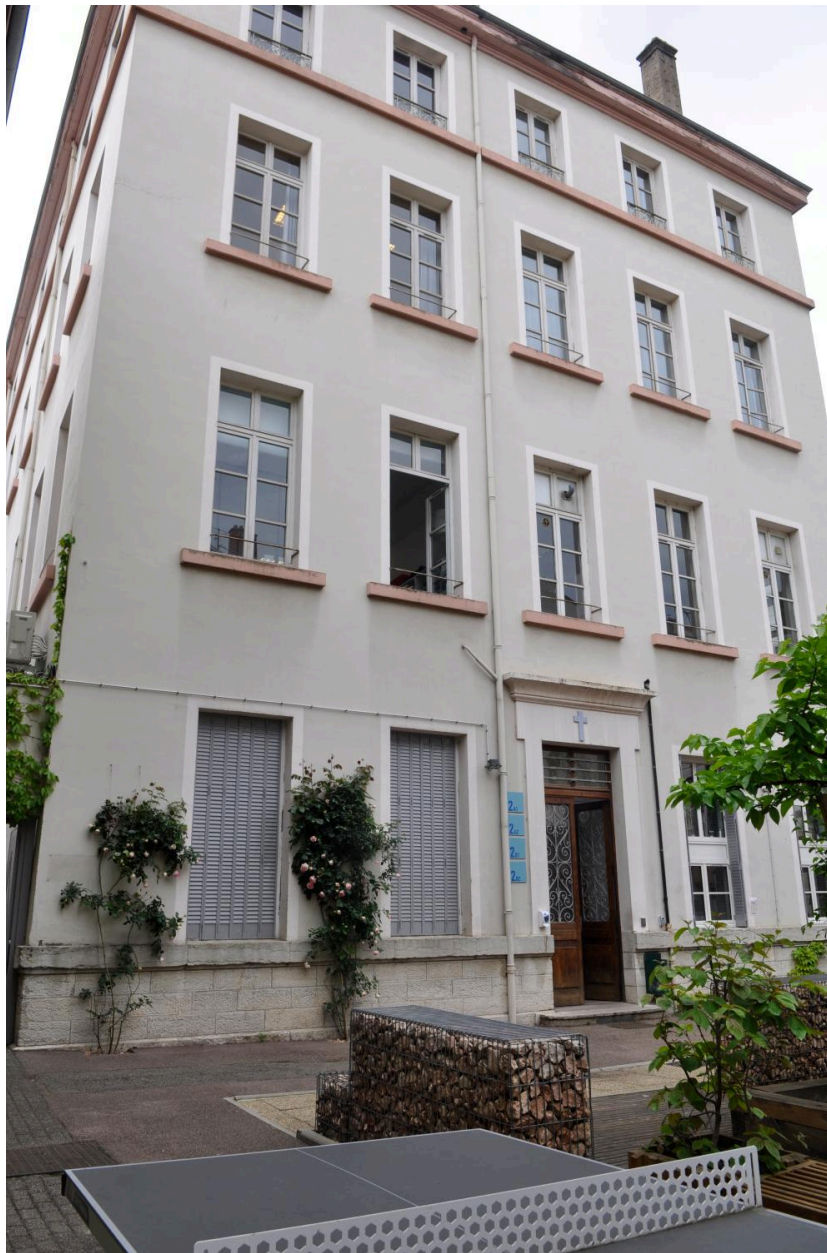
Bâtiment sur rue, élévation latérale
