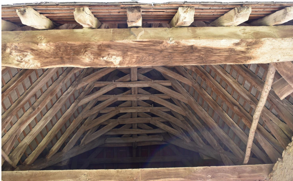
Charpente du auvent de la grange n°1 : vue générale
