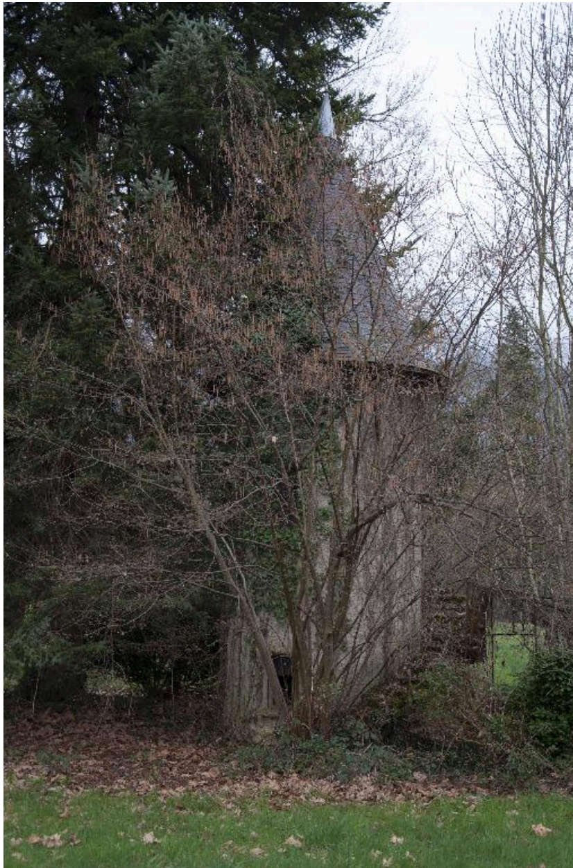
La tour ronde, ou pigeonnier, avec son escalier extérieur, vue générale depuis le nord-ouest
