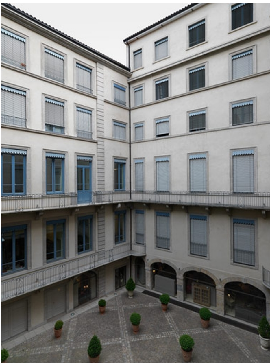
Vue de l'élévation à l'angle nord-ouest de la cour
