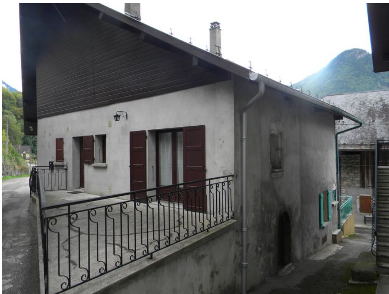
Vue de la face nord d'une ancienne maison conservant des encadrements anciens (2008 B4 444, 1793)
