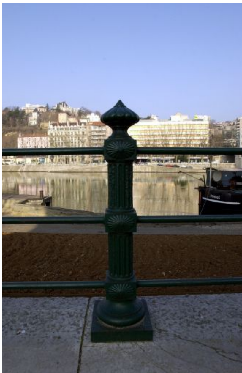
Détail d'un balustre du garde-corps
