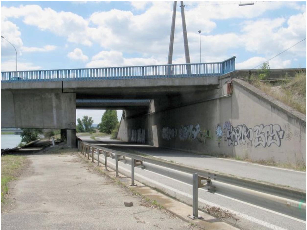
Culée passante de la rive droite, face amont
