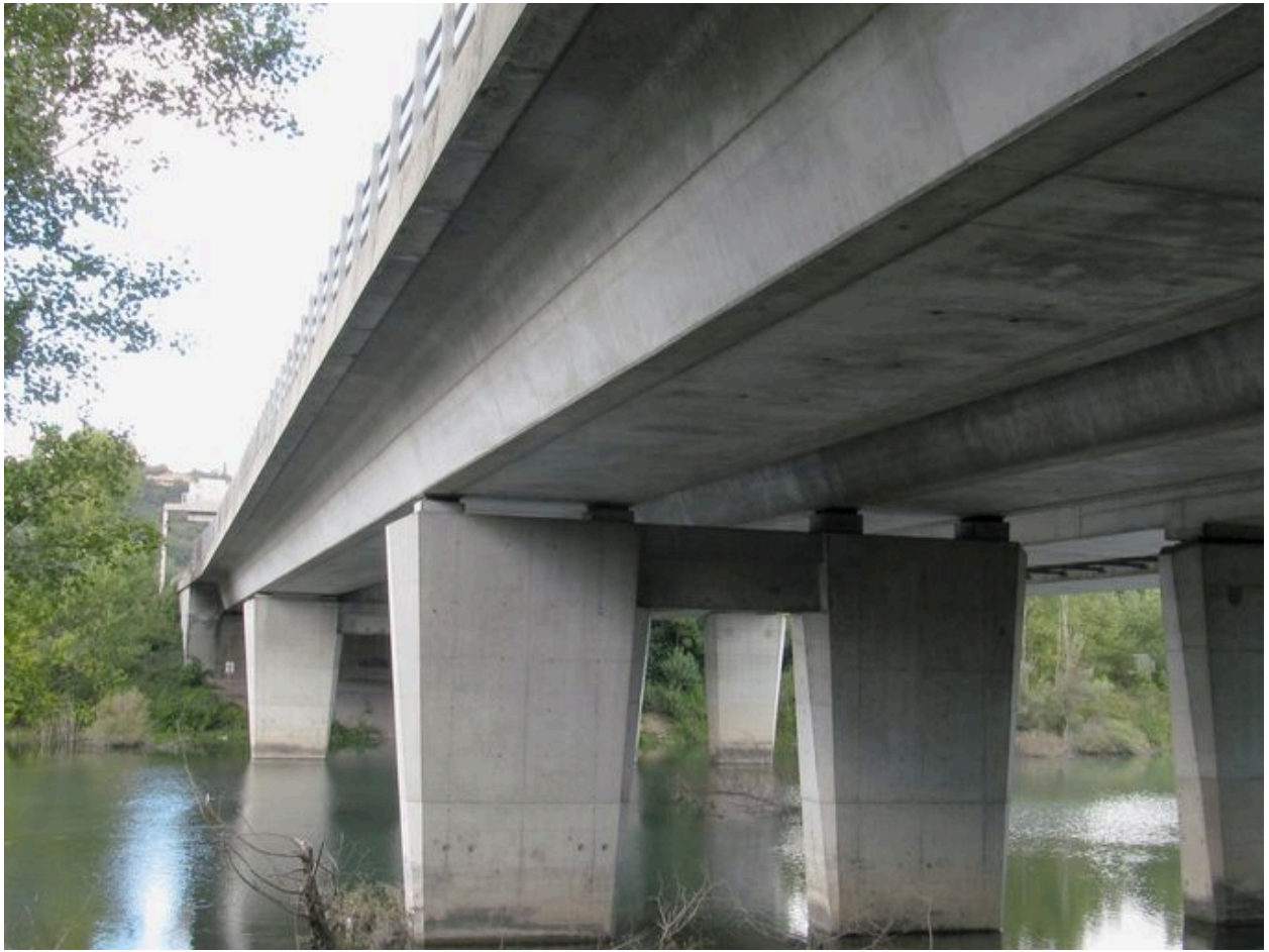
Vue latérale, face aval (depuis la rive gauche)
