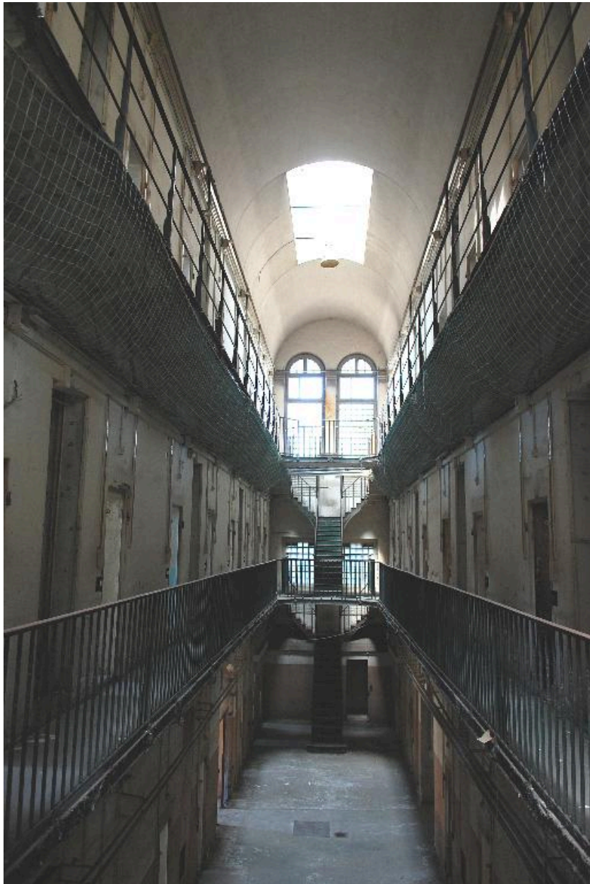
Etat en 2010 : l'aile nord depuis le premier étage
