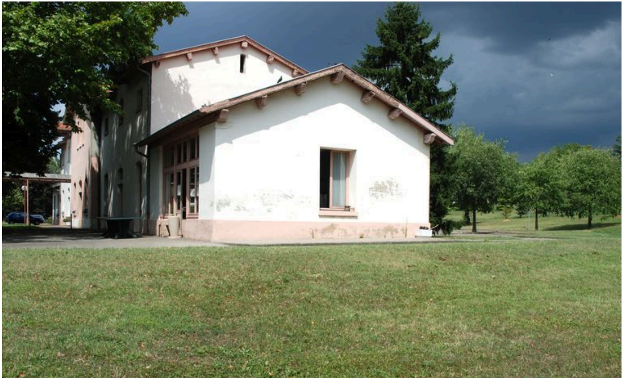
Ancienne boulangerie, façade latérale sud
