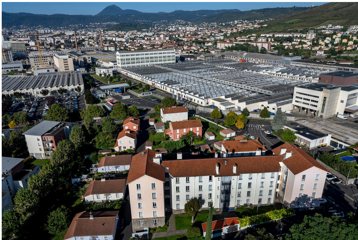
Vue aérienne partielle de la cité ouvrière.
