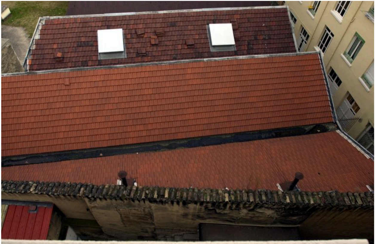
Vue du mur séparant la cour de l'immeuble 3 rue de l'Abbé-Boisard du corps de bâtiment couvert en sheds
