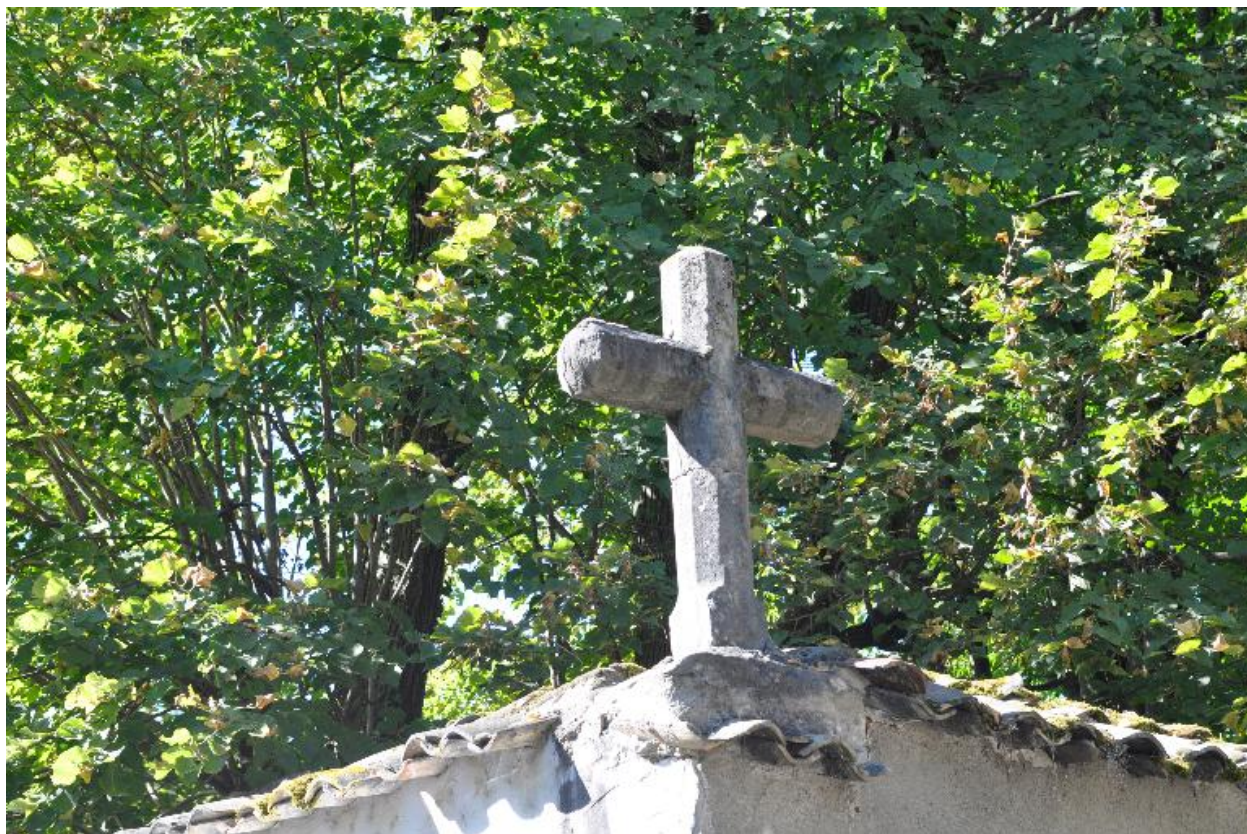
Détail de la croix à l'angle du mur de clôture
