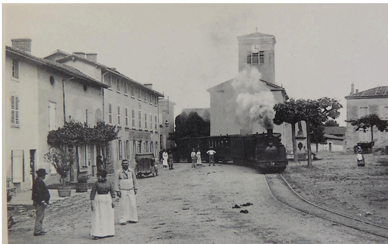
Ci-dessus, un train des Chemins de fer Économiques du Sud-Est dans la traversée de la localité de Villeneuve, et à droite la gare du même nom, dotée d'un bâtiment de 2ème classe.
