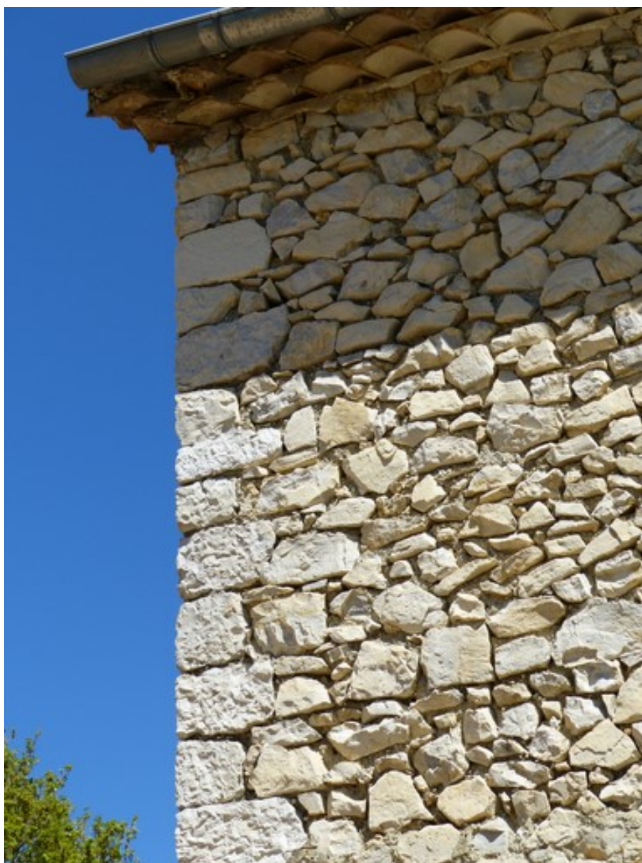
Chaîne d'angle d'une ferme, quartier du Moulin.
