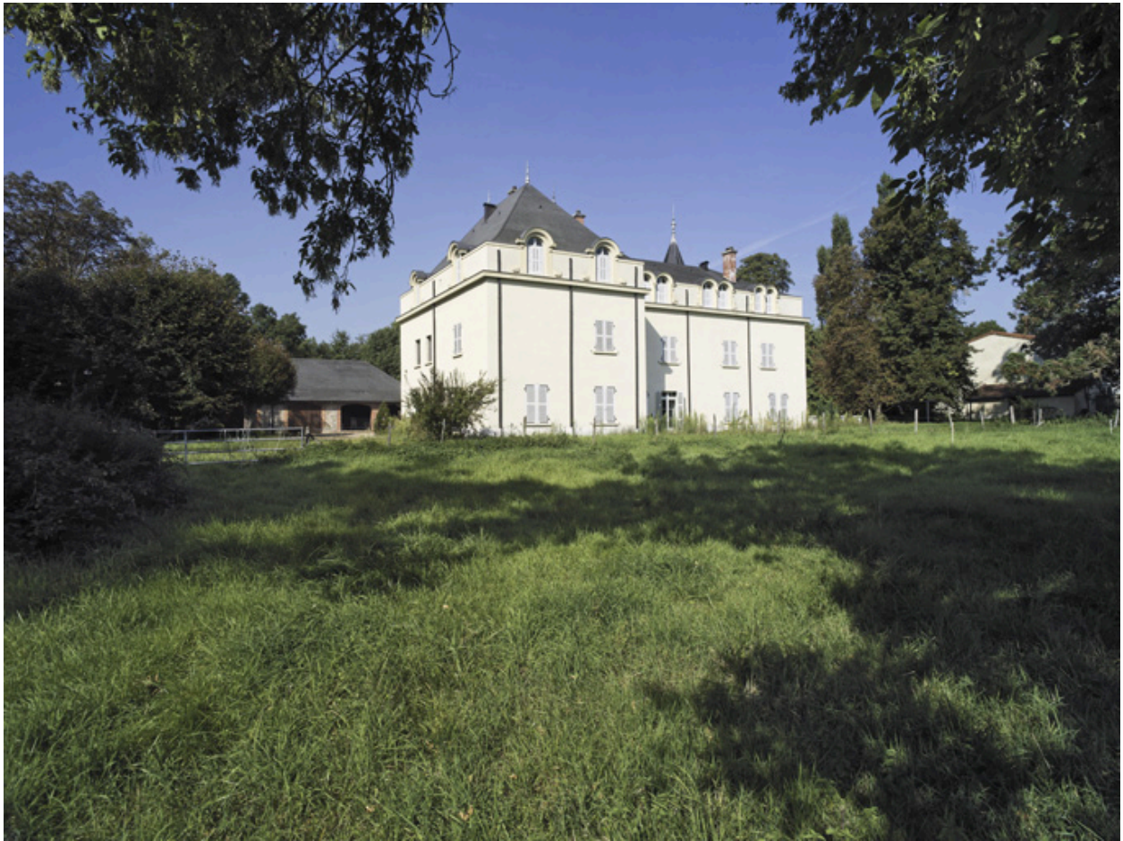
Vue d'ensemble de la demeure, depuis le sud-est.
