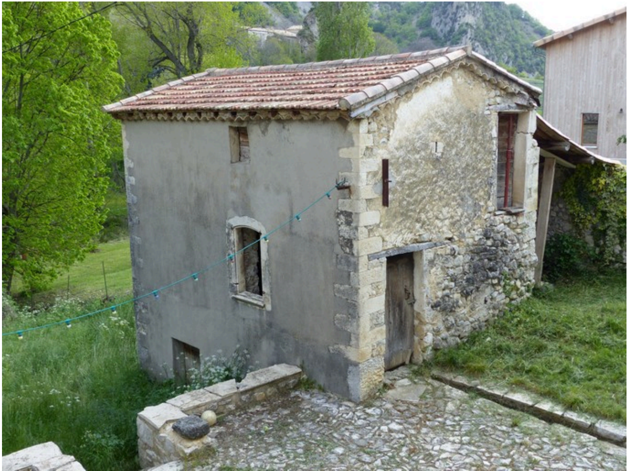
Dépendance sud-ouest. Vue d'ensemble prise du nord-est.
