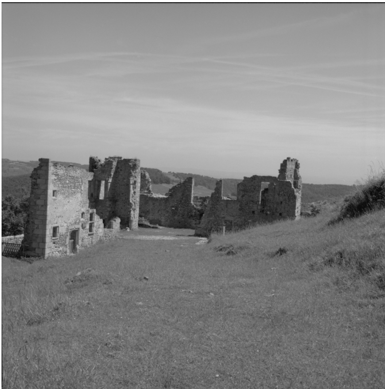
Premier baile, partie nord, première enceinte : vue d'ensemble de l'angle nord avec le logis du Capitaine à gauche, du sud-ouest.
