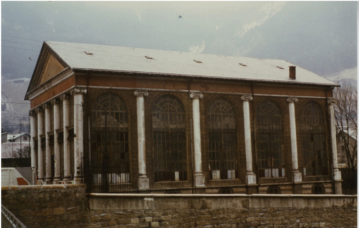
Vue façade nord
