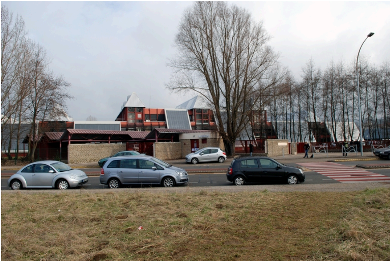
Bâtiment A. Vue d'ensemble depuis le sud-est
