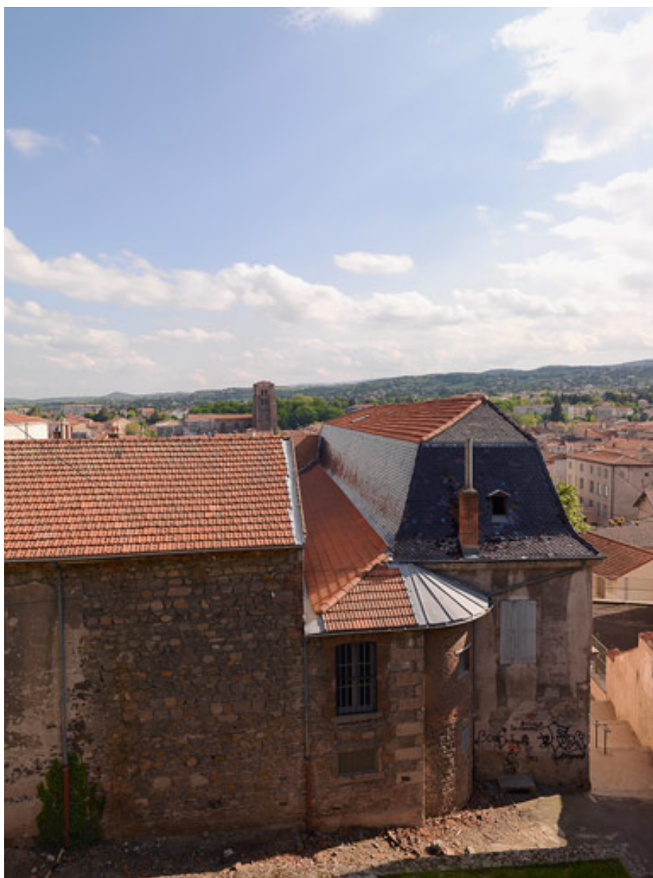
Vue partielle, raccordement de la chapelle du côté de l'entrée avec le bâtiment A.
