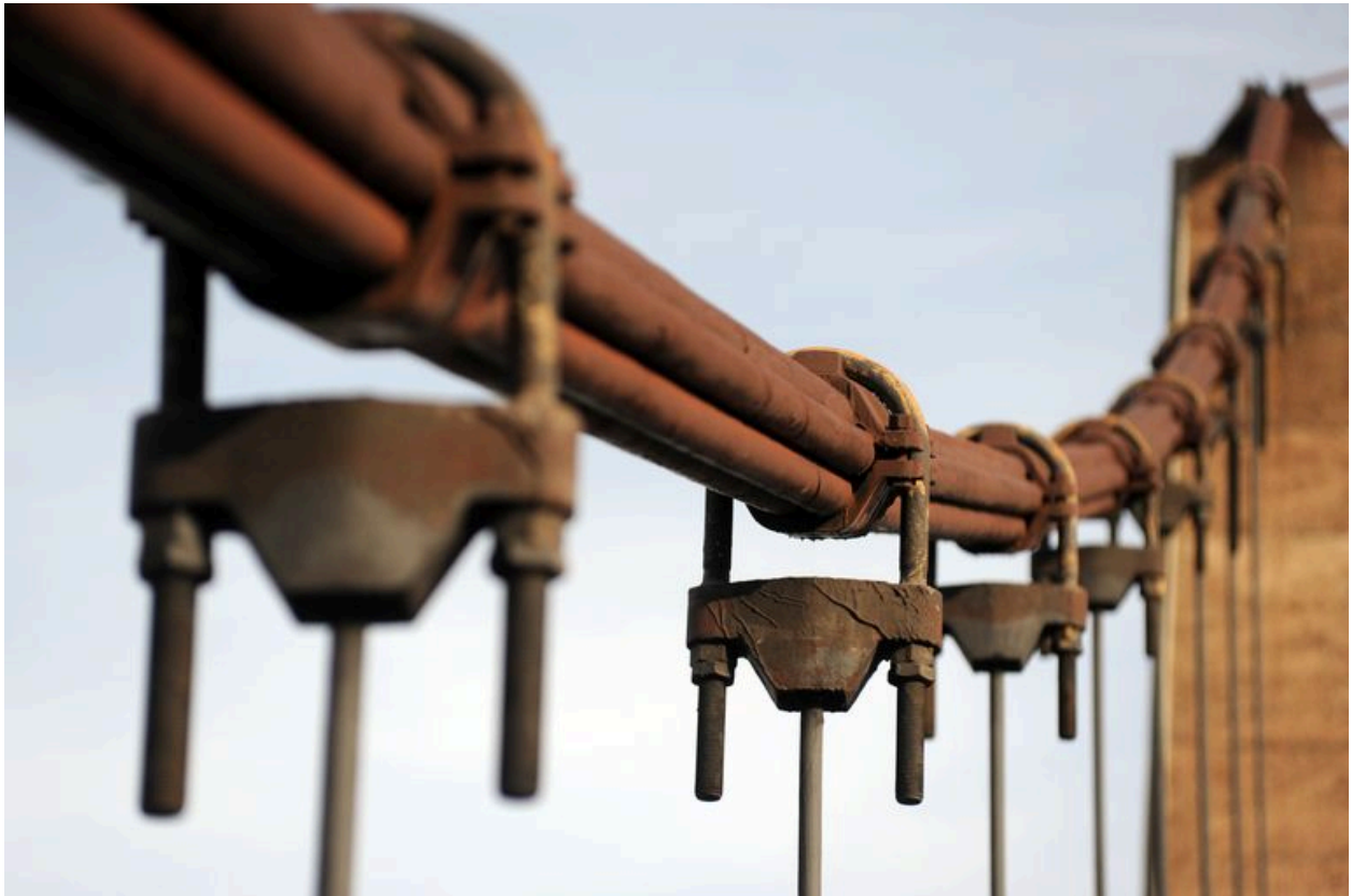
Suspentes, vue partielle : jonctions avec le câble porteur (depuis la rive droite)
