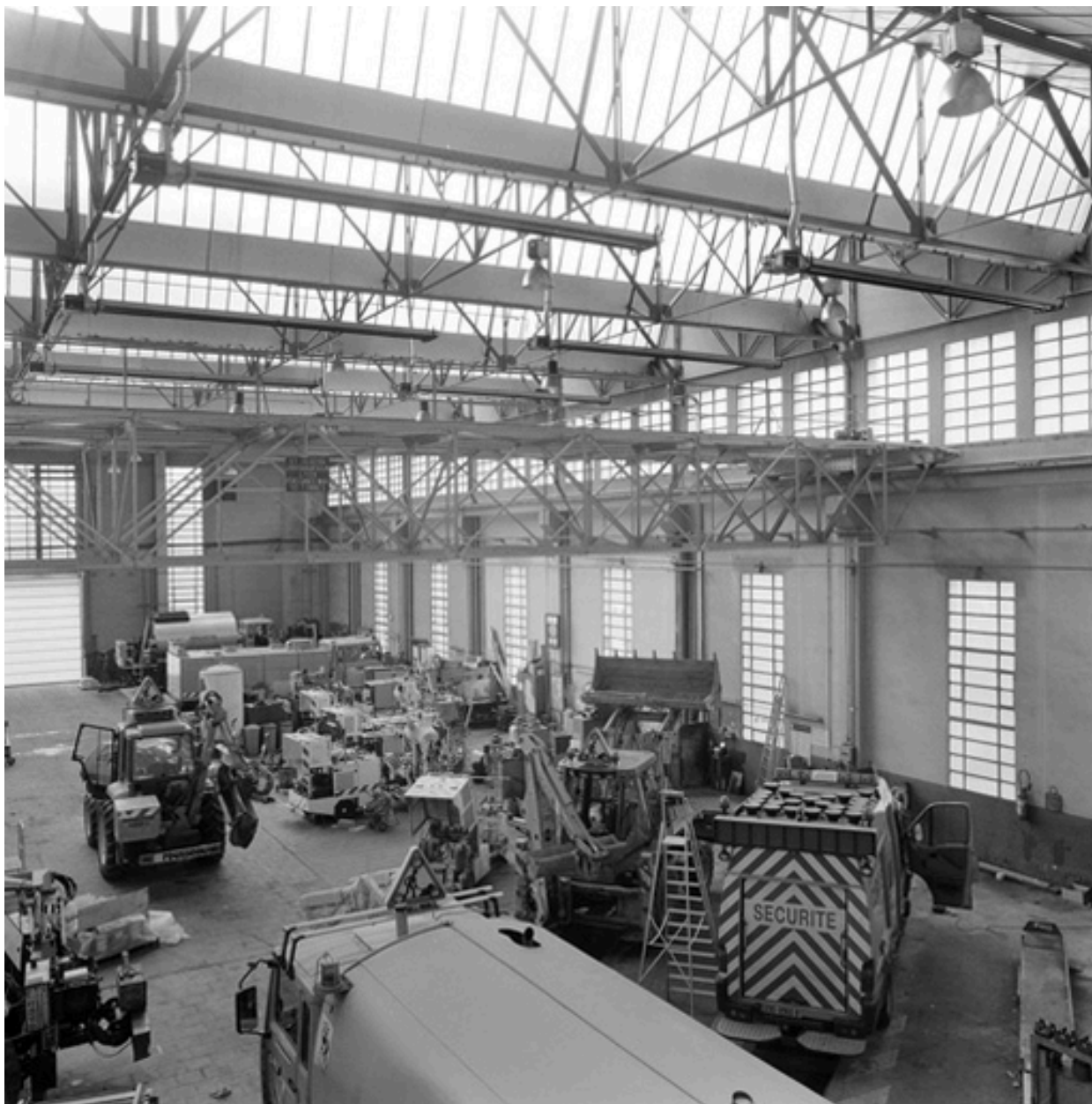
Vue d'ensemble de l'intérieur du grand hall
