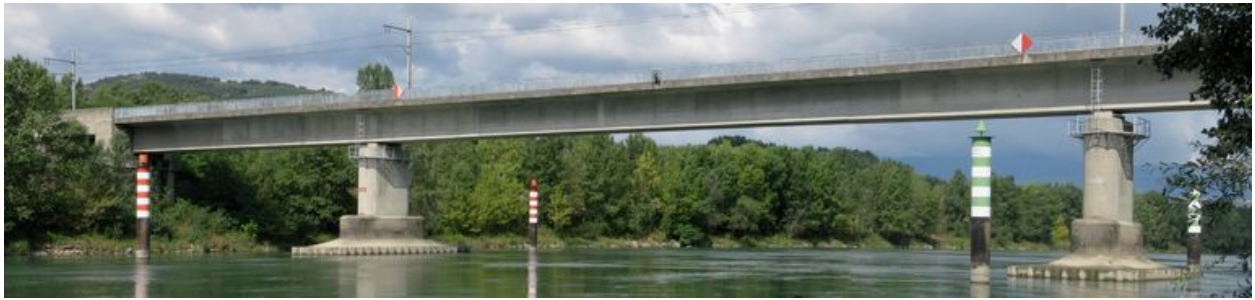
Vue panoramique, face aval (depuis la rive gauche)
