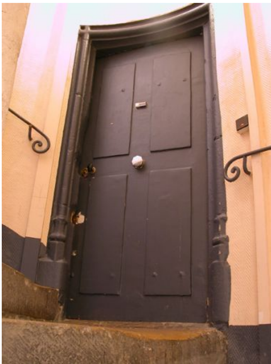
Escalier, porte du 2e étage
