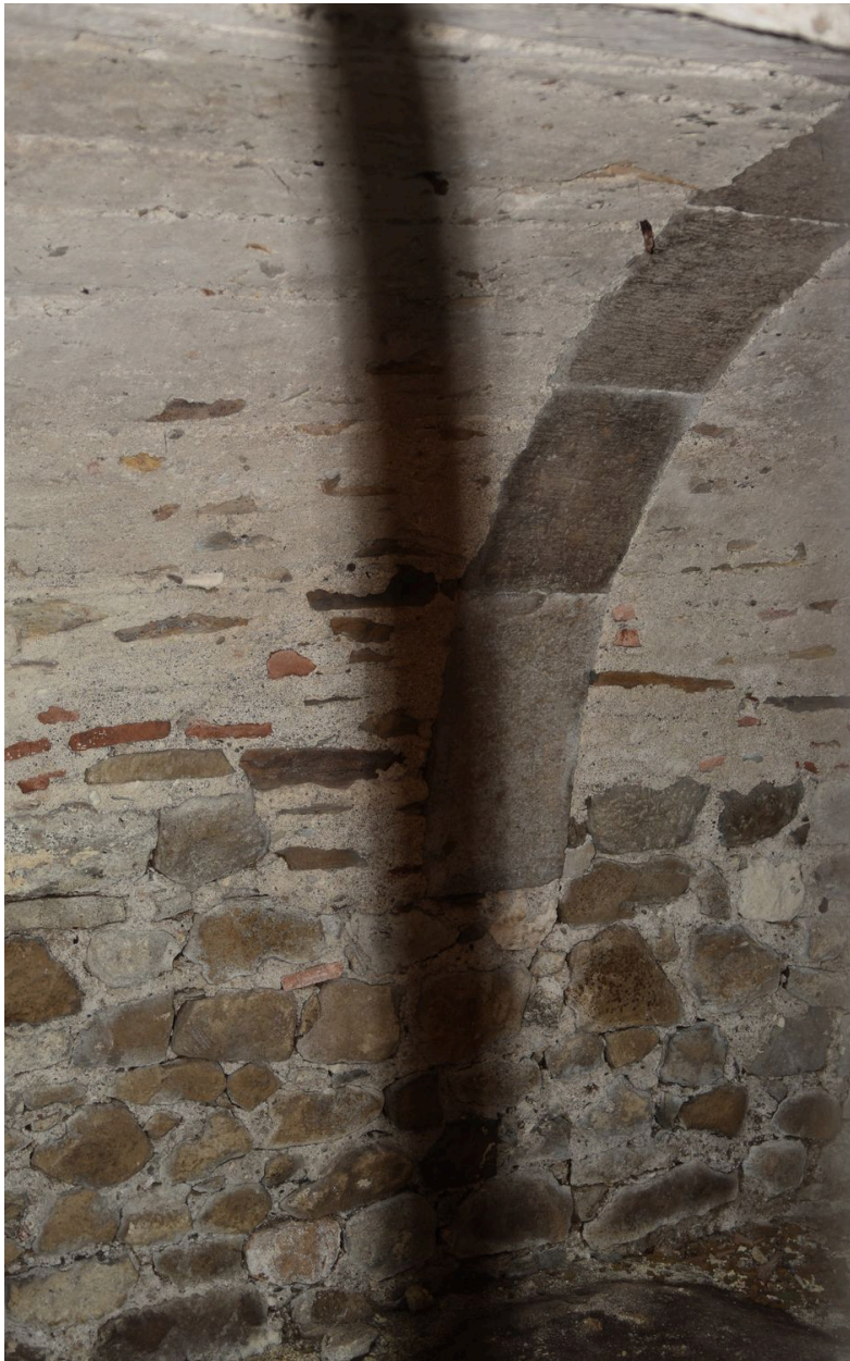
Petite cave semi-enterrée sous le 1er palier de l'escalier principal
