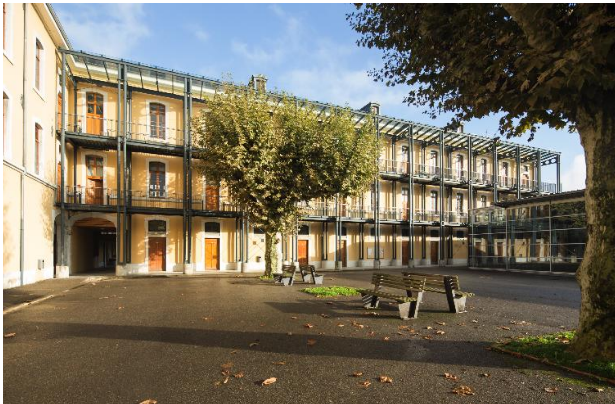
Cour 1 : vue générale vers le gymnase.
