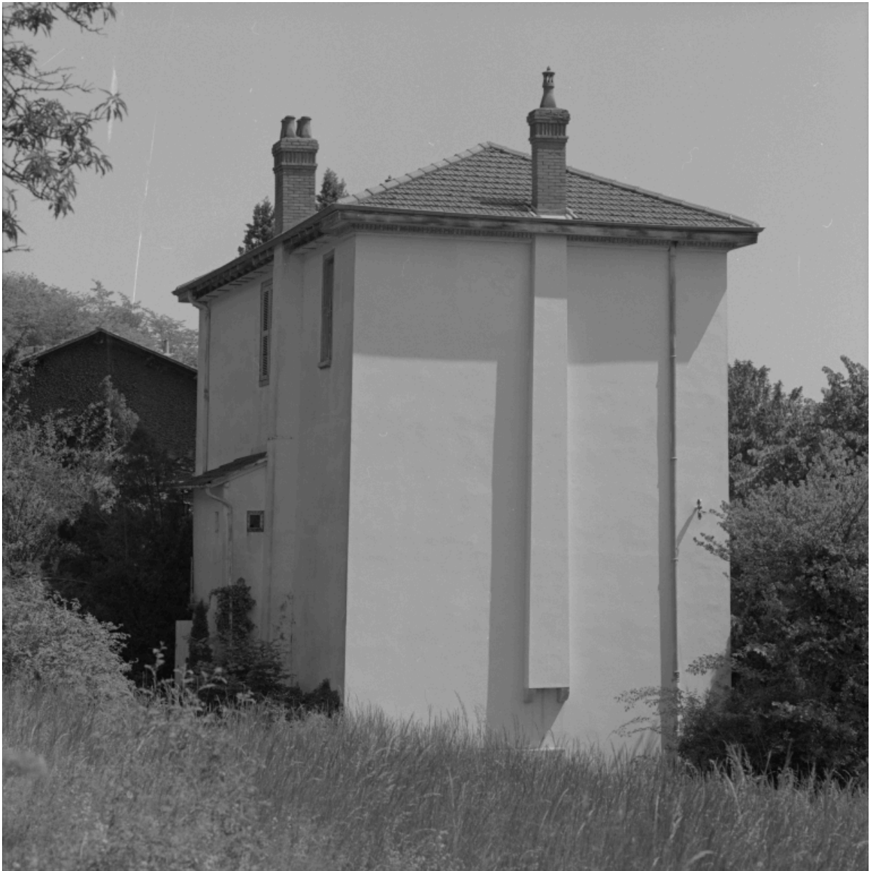
Maison de notable (type VII), dite Les Yuccas, 10 boulevard de l'Industrie (détruite après inventaire) : vue dans le site, élévations postérieure et latérale gauche
